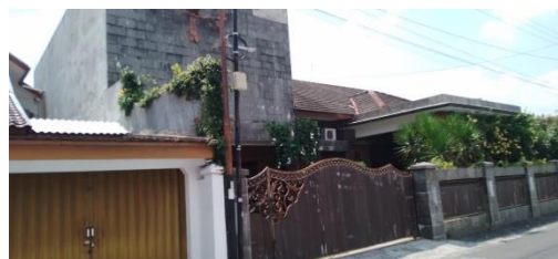
Gambar 5. Material atap sebagian bangunan pada kawasan Pakualaman Sumber: Dokumentasi penulis, 2024
