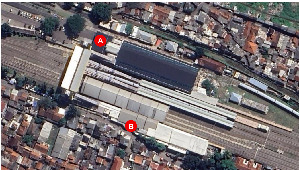
Gambar 1. Posisi pintu masuk utara/bangunan baru (a) dan pintu masuk selatan/bangunan lama (b) Stasiun Kereta Api Kiaracandong
