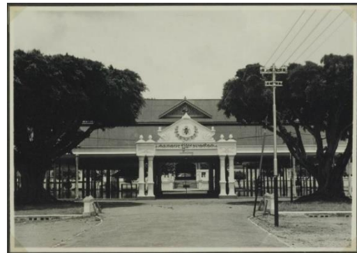
Gambar 5. Bentuk bangunan keraton setelah gempa 2006
